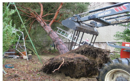
Sécurisation d'une habitation
